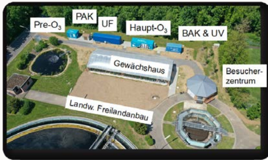
Pilotprojekt KA Schweinfurt, Aufbau der Wasseraufbereitung (Quelle: Initiative WavE)
